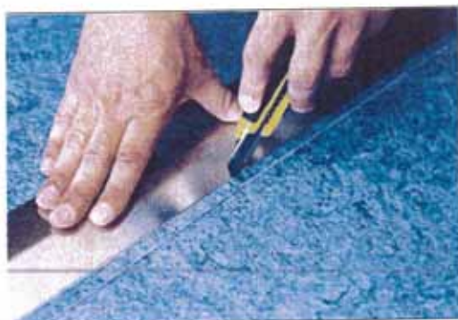
Belagsbahnen werden überlappend ausgelegt und entlang einer Metallschiene durchgeschnitten. Schnittreste werden entfernt und der Nahtbereich am Unterboden fixiert.
