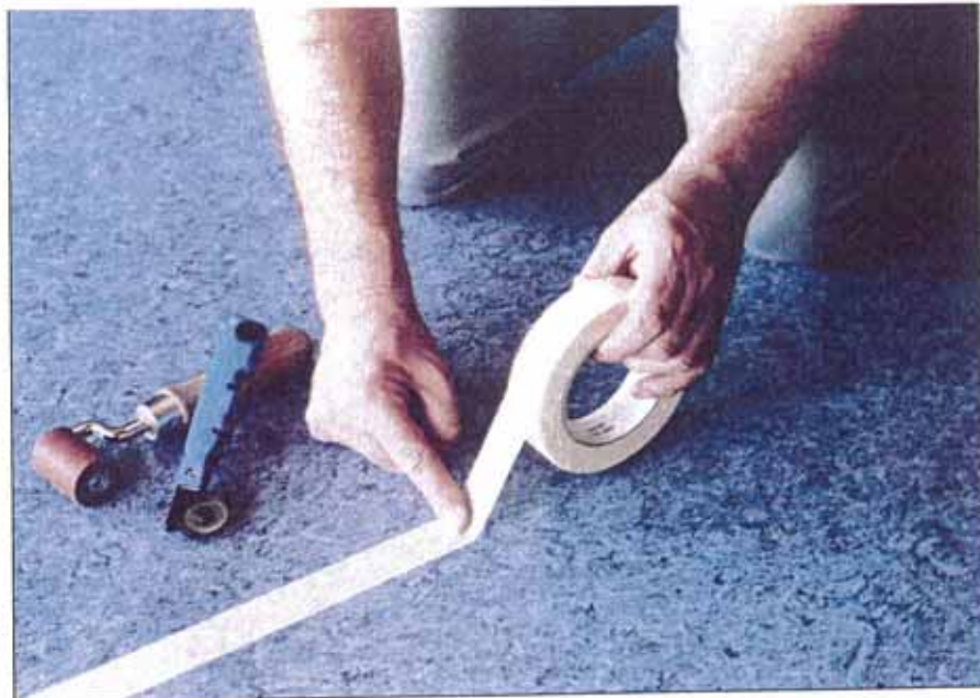
Ein Klebeband wird mittig auf die Naht aufgebracht.
