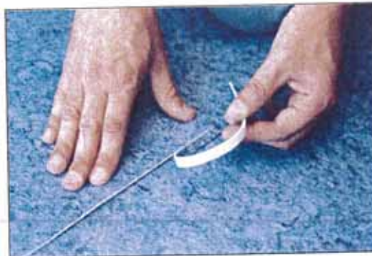
Belagsbahnen werden überlappend ausgelegt und entlang einer Metallschiene durchgeschnitten. Schnittreste werden entfernt und der Nahtbereich am Unterboden fixiert.
