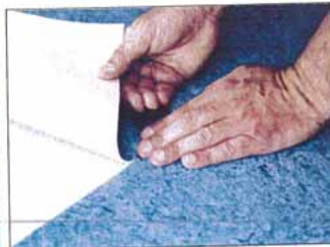
Belagsbahnen werden überlappend ausgelegt und entlang einer Metallschiene durchgeschnitten. Schnittreste werden entfernt und der Nahtbereich am Unterboden fixiert.
