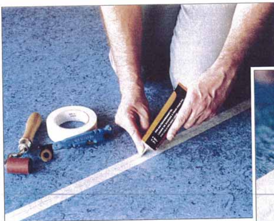
Einbringen des Kaltschweißmittels.
